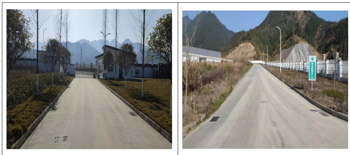
图 2-7 进场道路现状图（左侧为人行出口，右侧为垃圾运输进出口）
