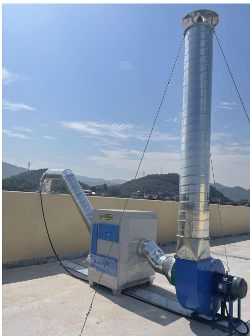
图 4-2 注塑废气收集示意图
