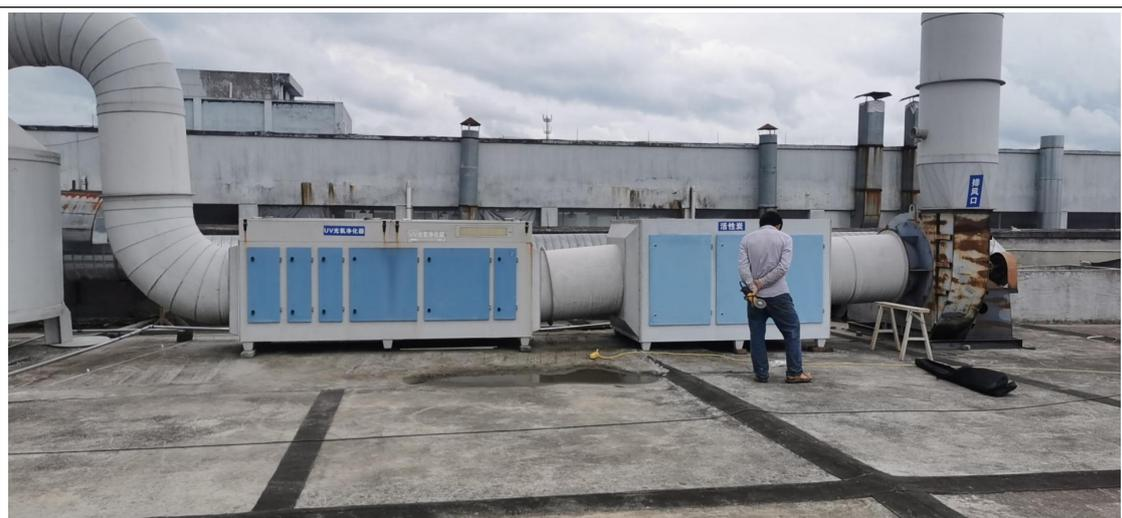
图3-3 有机废气处理设施
